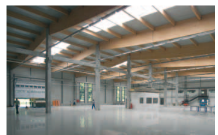
Innenansicht: Hronská Breznica
